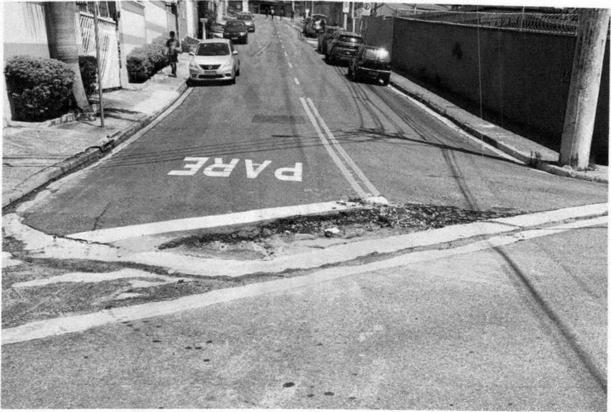
Manutenção asfáltica no cruzamento da Rua Giuseppe Muffo com Rua Roberto Nabuo Sato, Vila Cintra -Mogi das Cruzes.
